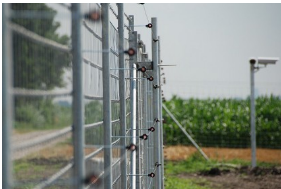
Rysunek 2. Przykładowe ogrodzenie farmy fotowoltaicznej.
